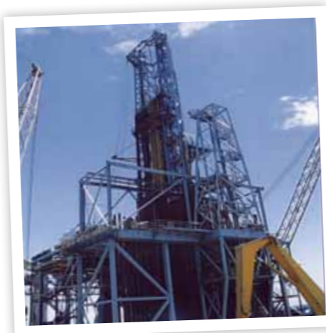
Het werk bleek op iets hoger niveau te zijn dan verwacht... (Foto: Ton Kraak, Aludra BV, Vlaardingen)
