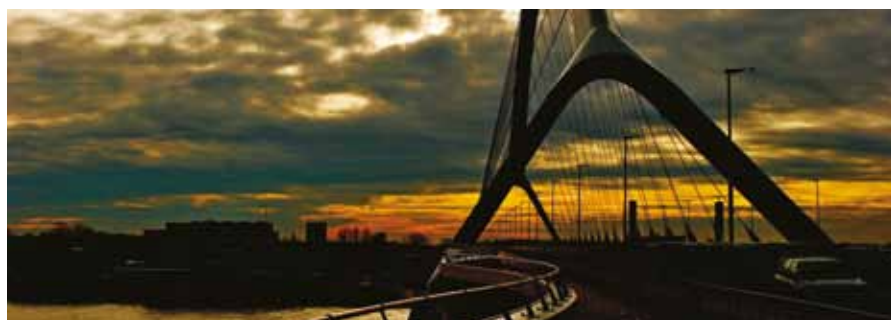
De brug bij Nijmegen, "de Oversteek". (Foto: Stein Venmans, BAM)
