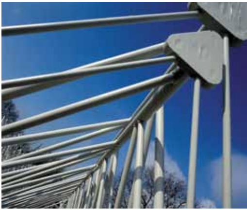
Duplexsystemen geven een robuuste bescherming in de gewenste kleur. De verzinkte, nog ongecoate constructie is op de voorpagina van deze editie afgebeeld.
