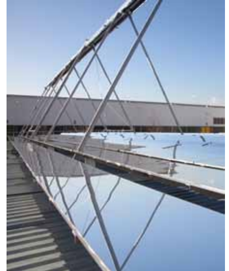
Moffelen met spiegels; dat werpt een ander licht op thermische oppervlaktebehandelingsprocessen. (Foto: Dürr Systems GmbH)
