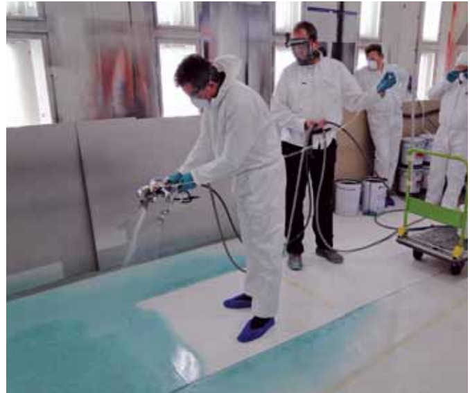
Twee nozzles spuiten diagonaal de coating op, en waar de coatingstromen samenkomen wordt een versnipperde glasvezel gedoseerd. De deelnemers mochten het zelf ook proberen.
