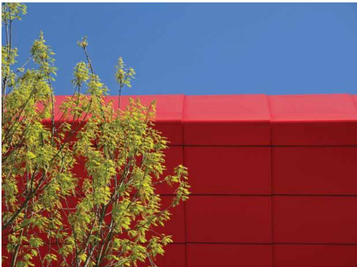
De overlappende detaillering geeft bij het langsrijden een verlevendigend effect, maar bracht enige hoofdbreken wat inwatering betreft. (Foto: Henkje, Shutterstock.com)
