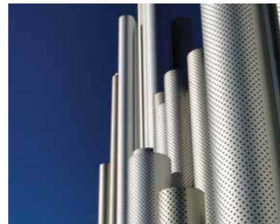
Het modelvoorbeeld van de buizen, deze zijn nog geboord in plaats van gestanst zoals de uiteindelijke productieseries.
