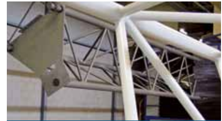
Goed straalwerk is essentieel voor het eindresultaat.
