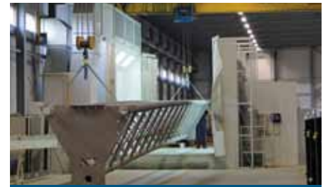
De ligger van een portaal op weg naar de lakkerij.
