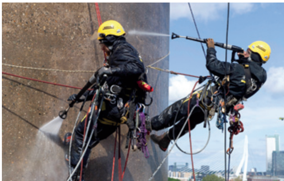
De spuitlans en nozzle zijn enkele procesparameters die per project afgestemd worden op het uit te voeren werk. (foto: David Franck Photographie)
