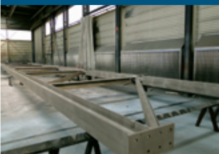
Vakwerkspant na het stralen.
